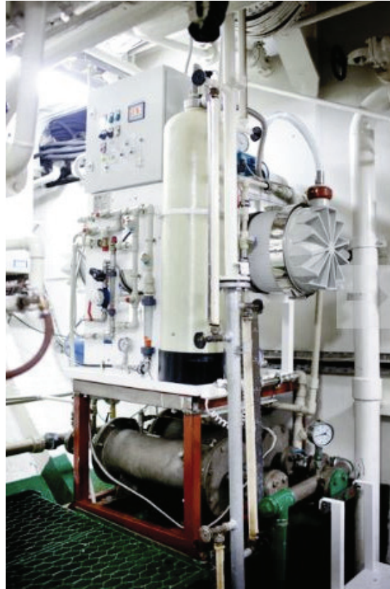
Fig. 7. Prototypical DOE Pelican desalinator installed on s/v Dar Młodzieży (phot. Adam Kasprzak) [4]
